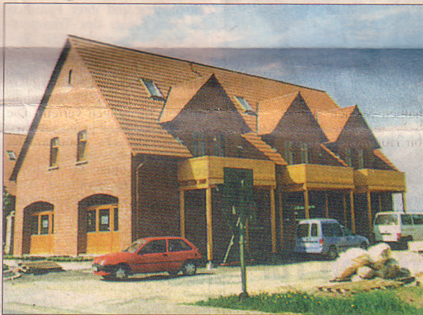
Holz und rote Klinker beherrschen die Außensicht. Sieben Wohnungen sind bereits vermietet
